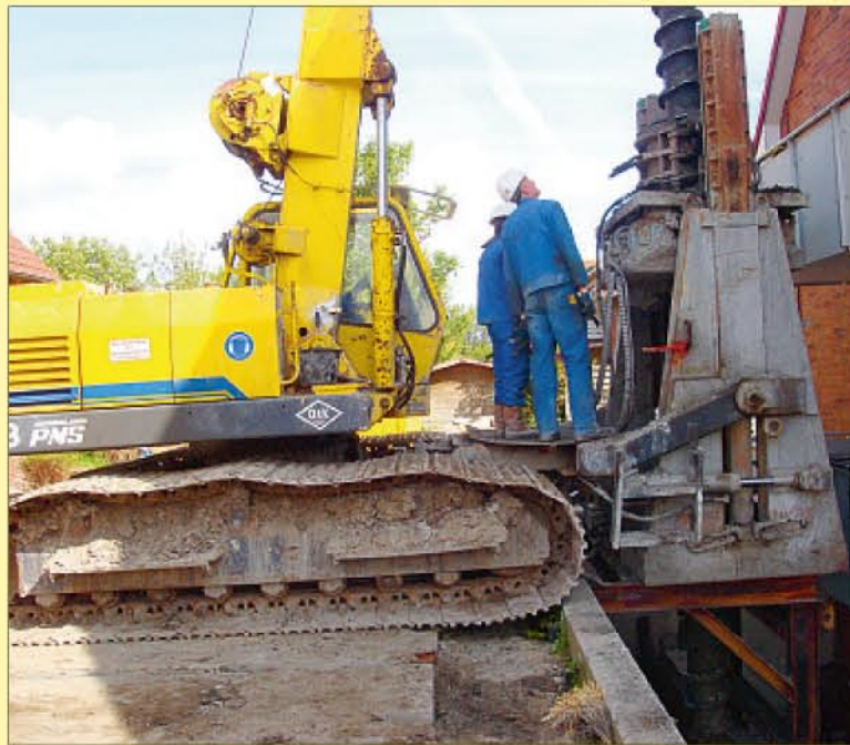
Nicht jede Bohrung ist gleich. Ingenieurwissen ist gefragt, wenn es wie hier um das Bohren mit Hilfsgestell geht.
