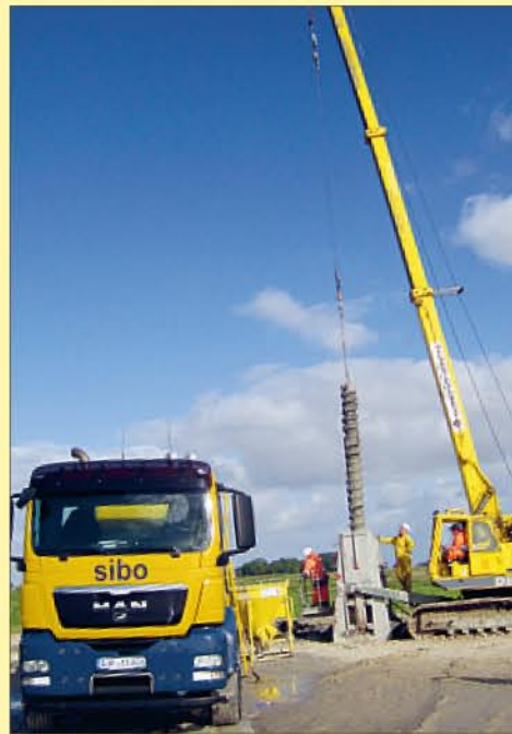
Bundesweite Aufträge für Pfahlbohrungen sind keine Seltenheit.
