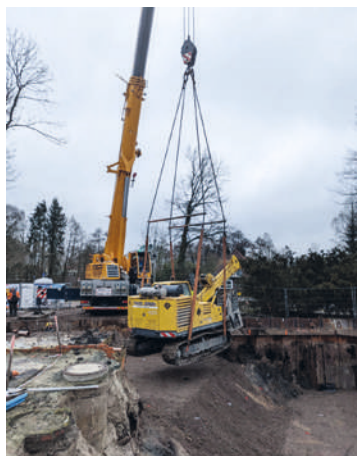
Im Freibad Rastede kommt ein Pfahlbohrgerät zum Einsatz
